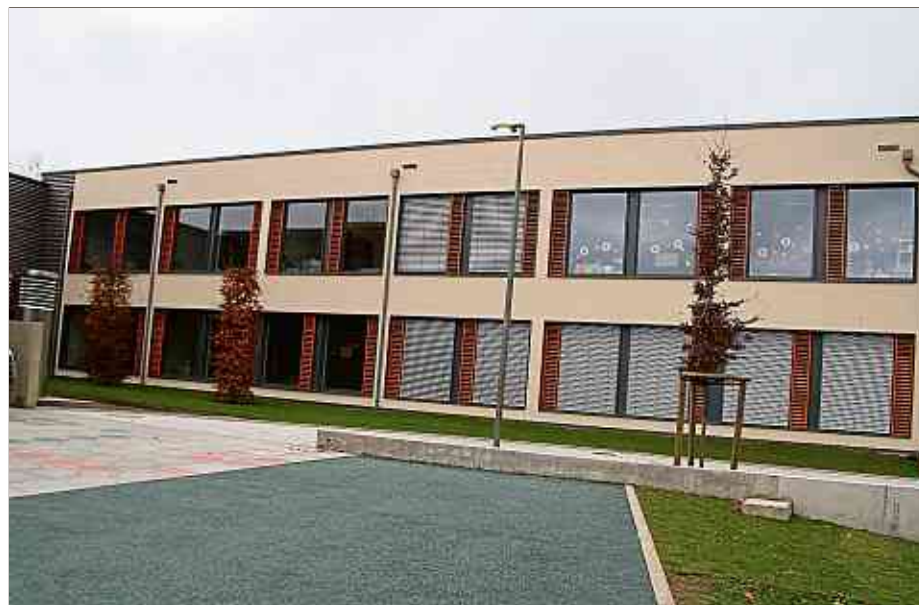
Der 3 170 m 2 große lichtdurchflutete Komplex wurde in knapp 14 Monaten in Niedrigenergiebauweise fertiggestellt. Kostenpunkt: 7,1 Millionen Euro.
